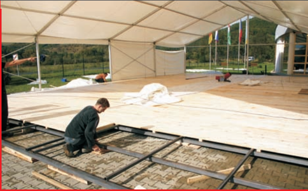
Seč - montáž podlahy
